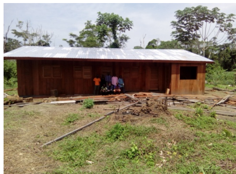
Construction d'un bloc de 02 salles de classe et d'un bureau à l'école publique de Socambo
