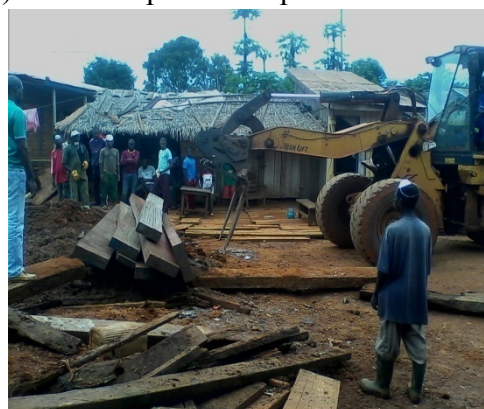
Contribution de la SEFAC à la reconstruction d'un pont dans le centre ville de Libongo
